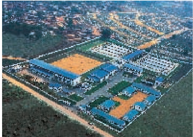
Loji Rawatan Air Binh An di Bandar Ho Chi Minh, Vietnam
