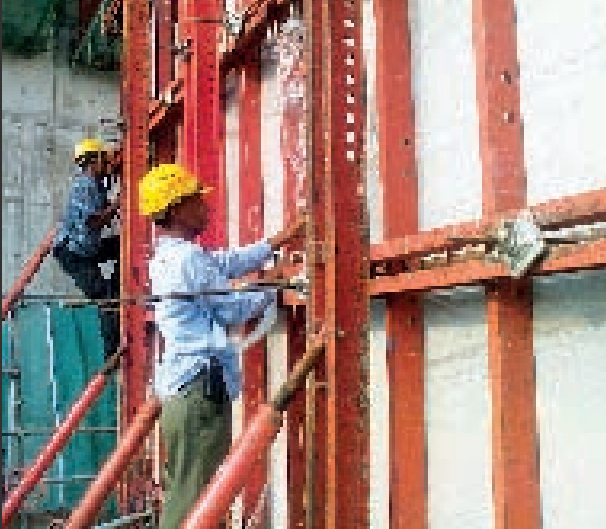
Struktur-struktur yang dibina diperiksa bagi pemasangan berkualiti dan betul
