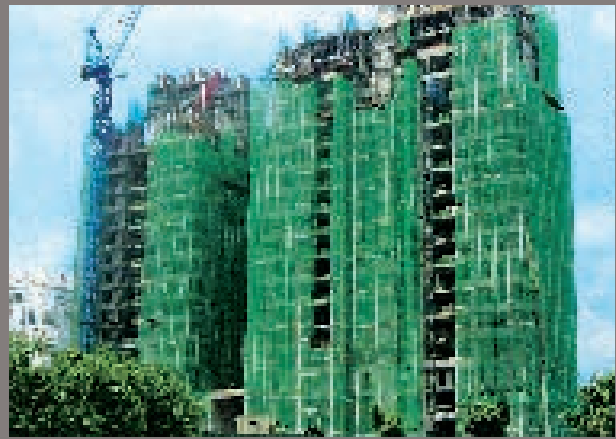
Pemasangan jejaring tepi diamalkan di tapak-tapak bangunan bagi keselamatan
