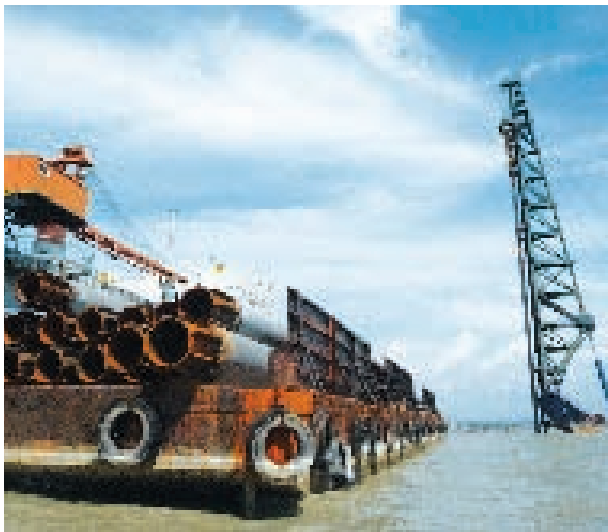
Cerucuk digunakan di Jambatan Kedua Pulau Pinang
